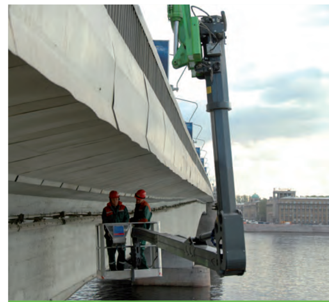
Il Sistema Space consente di operare ad una quota negativa di oltre 9 metri sotto il piano stradale.
